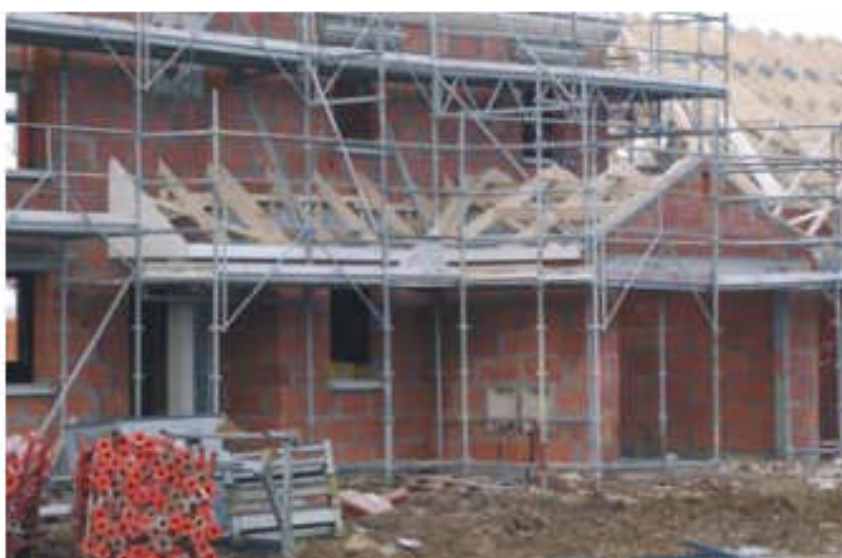
Figure 3. Échafaudage de pied
